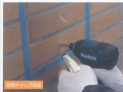
アンカーピン固定穿孔
